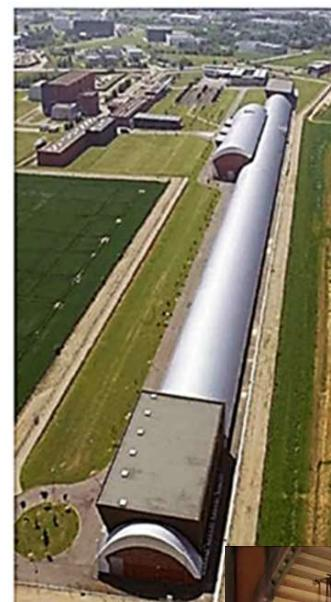
Une plate-forme de 120 tonnes circulant sur rails est capable de traîner des modèles jusqu'à 12m/s. De plus on peut y générer une houle de plus de 1m.
